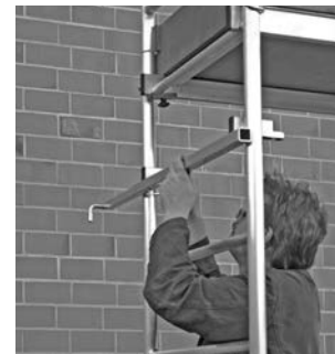
Podstawa rusztowania z pierwszą kondygnacją.
