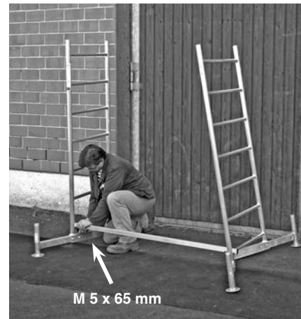
Podstawa rusztowania z pierwszą kondygnacją.
